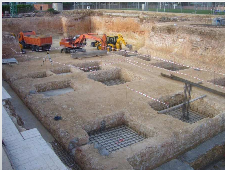
Proceso constructivo de placas de fundación aisladas
