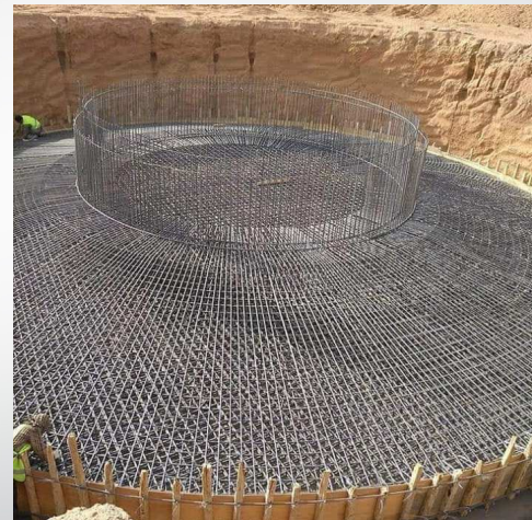
Placas de fundación (circular) de una torre de generación eólica
