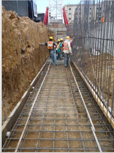
Fase de colocación del refuerzo en placa de un muro de retención
