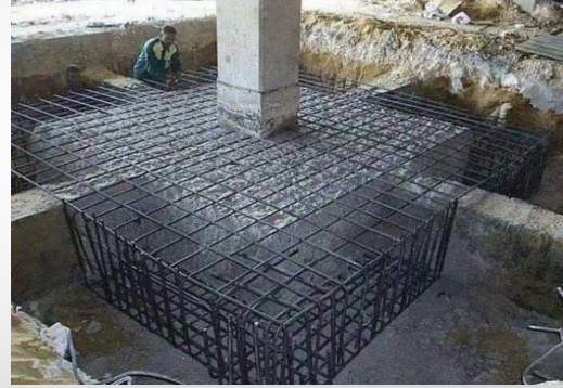
Recalce de cimentación como parte de un reforzamiento estructural
