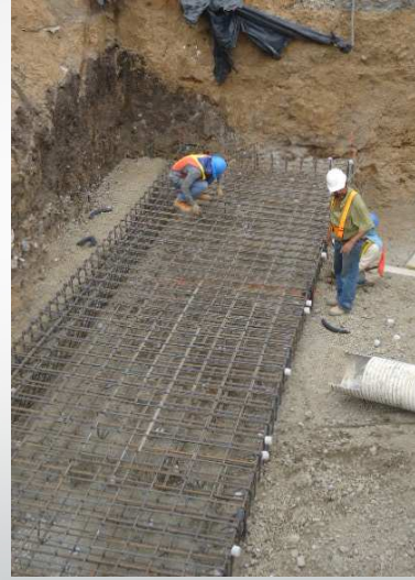
Fase de colocación del refuerzo en placa de un muro de retención
