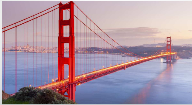
Los períodos fundamentales de vibración natural del Puente Golden Gate son: 18.2s (dirección transversal) y 10.9s (dirección vertical) y 3.81 (dirección longitudinal)
