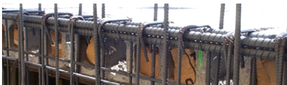
Relleno de celdas con cartón
