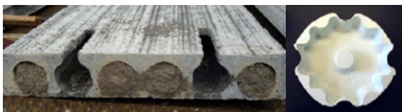
Relleno de celdas con concreto
