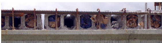
Relleno de celdas con sacos de cemento
