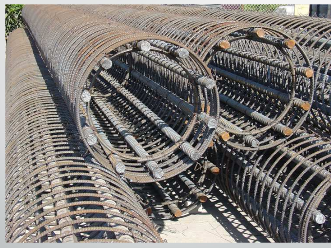
Empleo de armadura en pilotes
